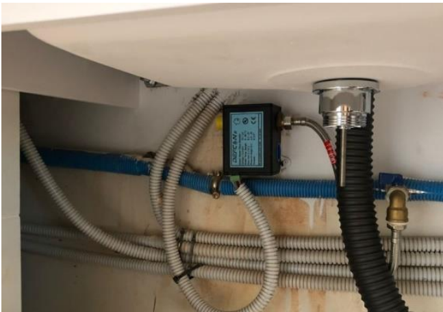
Fig 4. Monitorizacion solo 1 pica entre caudalímetros y display.
